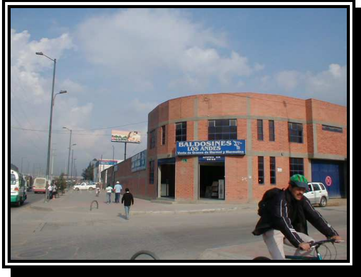
Fotografía N° 1 Inmueble ubicado en la Carrera 75 N° 57R-02 sur.
